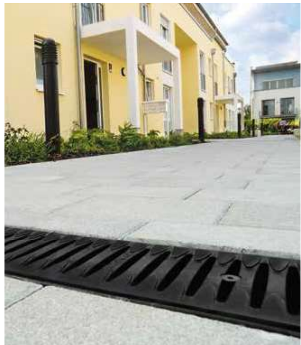
Complejo residencial en Múnich (Alemania)
