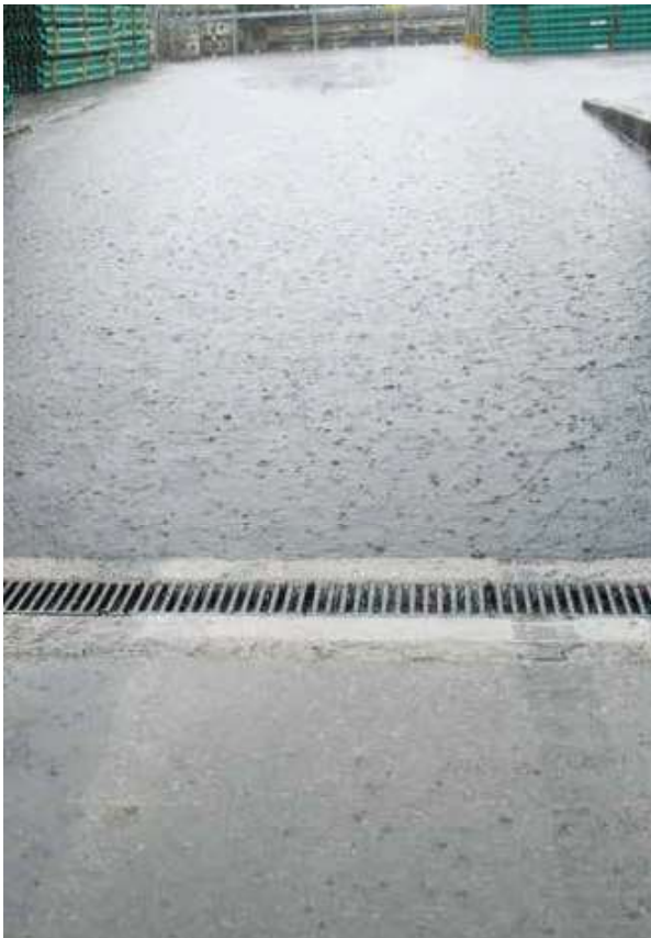
Vías de acceso
